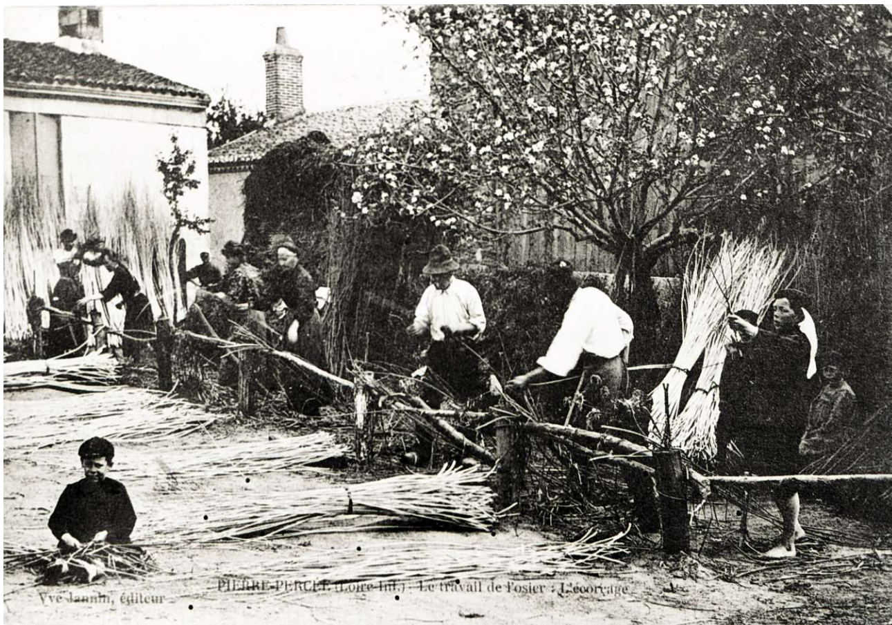
* Les piquets du chantier sont reliés comme souvent par une clôture de rondins...
